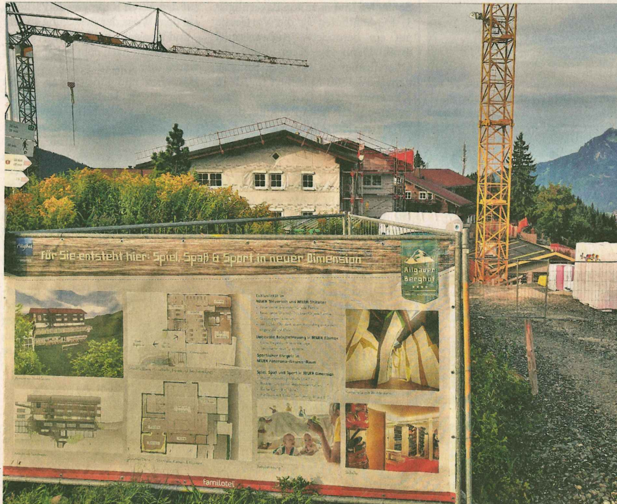
Der Allgäuer Berghof am Ofterschwanger Horn baut an. Das zur Hälfte im Gelände versenkte Gebäude kostet etwa zwölf Millionen Euro.
